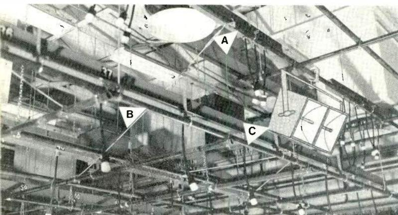
(A) UPPER GRID (B) LOWER GRID (C) TYPICAL CYCLORAMA LIGHTING FIXTURE
