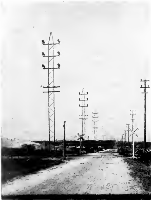
Fig. 7. Double-Circuit Steel Poles
