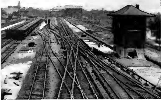
Fig. 13. "JE" Tower, Long Island R.R., Jamaica, N. Y.
