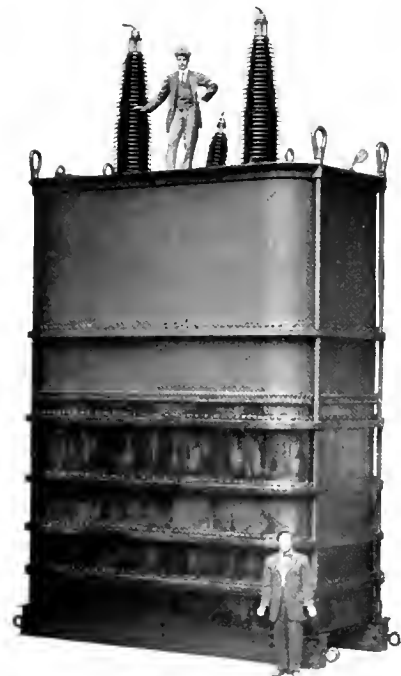
Fig. 3. 4500 Kw., 150,000 Volt Transformer
