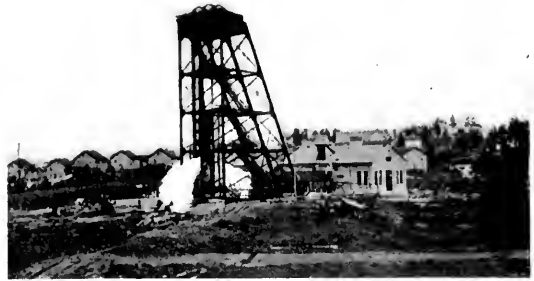
Fig. 2. Water Hoist at Hampton Shaft, D., L. & W. R. R., Hampton, Pa.
