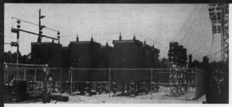
WORLD'S HIGHEST VOLTAGE-66-KV-HOUSED CAPACITORS PLUS BLOCKING REACTORS
