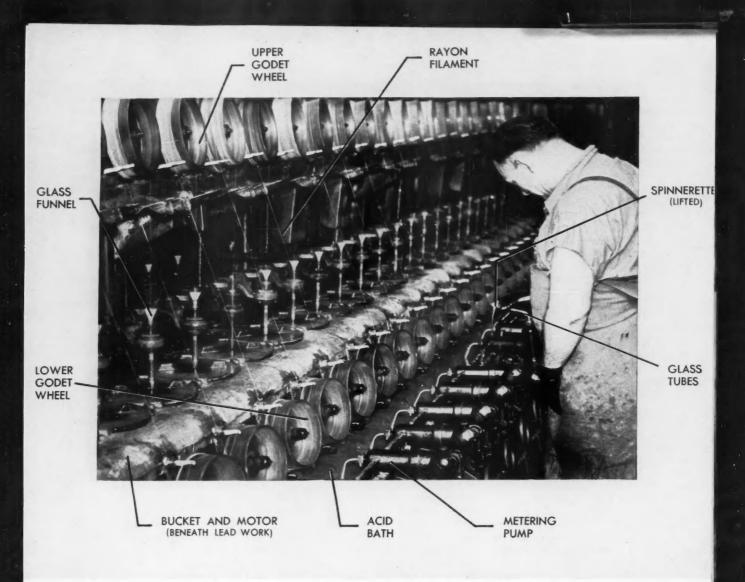
EARLY VISCOSE PROCESS OF SPINNING RAYON NOW PRODUCES THE MAJOR PORTION OF TODAY'S FIBER OUTPUT WITH HIGH-SPEED MOTORS.
