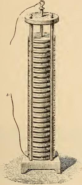
FIG. 113. VOLTA'S PILE
