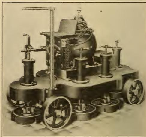
FIG. 2. SURFACING MACHINE FOR HEAVY WORK
