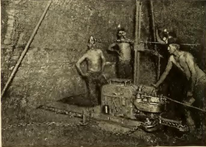
SCENE IN AN AUSTRALIAN MINE—THE UNDERCUTTING IS DONE BY SHARP BITS ON AN ENDLESS CHAIN. IN THE BACKGROUND IS AN AUGER DRILL MAKING BLAST HOLES
