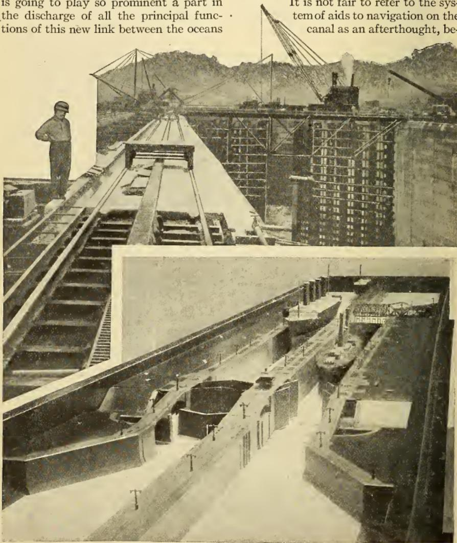
THE UPPER VIEW SHOWS PEDRO MIGUEL LOCK AND THE RACK TRACK WHICH WILL CARRY THE ELECTRIC TOWING LOCOMOTIVES. BELOW IS THE MODEL LOCK WHICH WILL OPERATE IN UNISON WITH THE REAL LOCK. FOR THE GUIDANCE OF THE MAN WHO CONTROLS THE LOCK GATES
