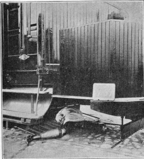
FIG. 3. WHEEL GUARD PICKING UP DUMMY.
