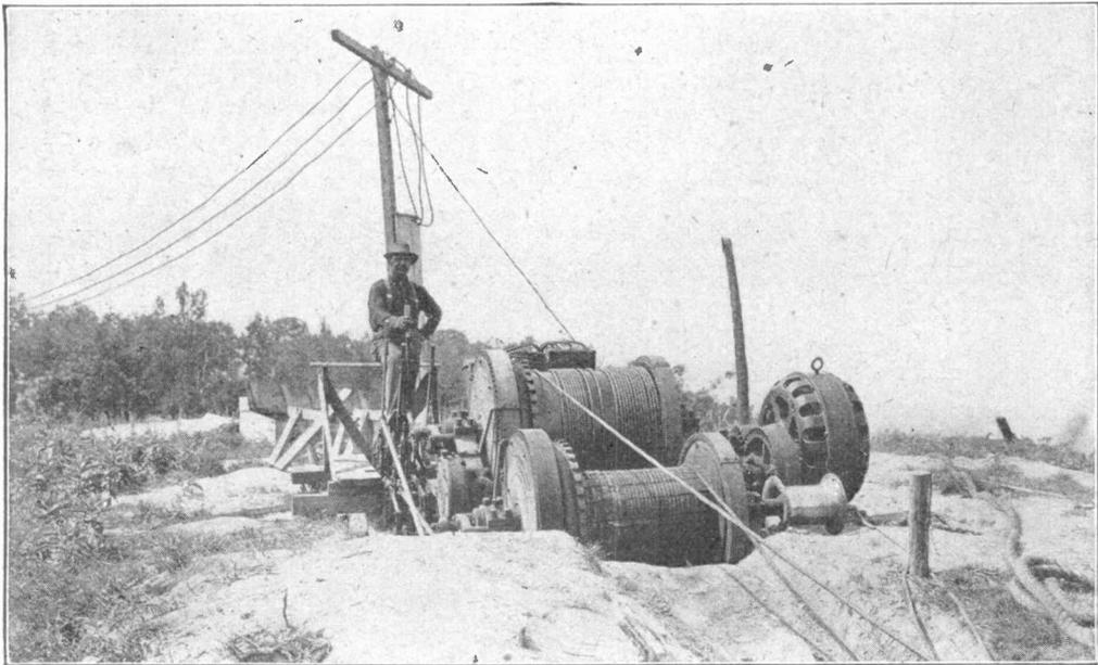
UTILIZING THE ELECTRIC HOIST TO DRAW A SCRAPER.
