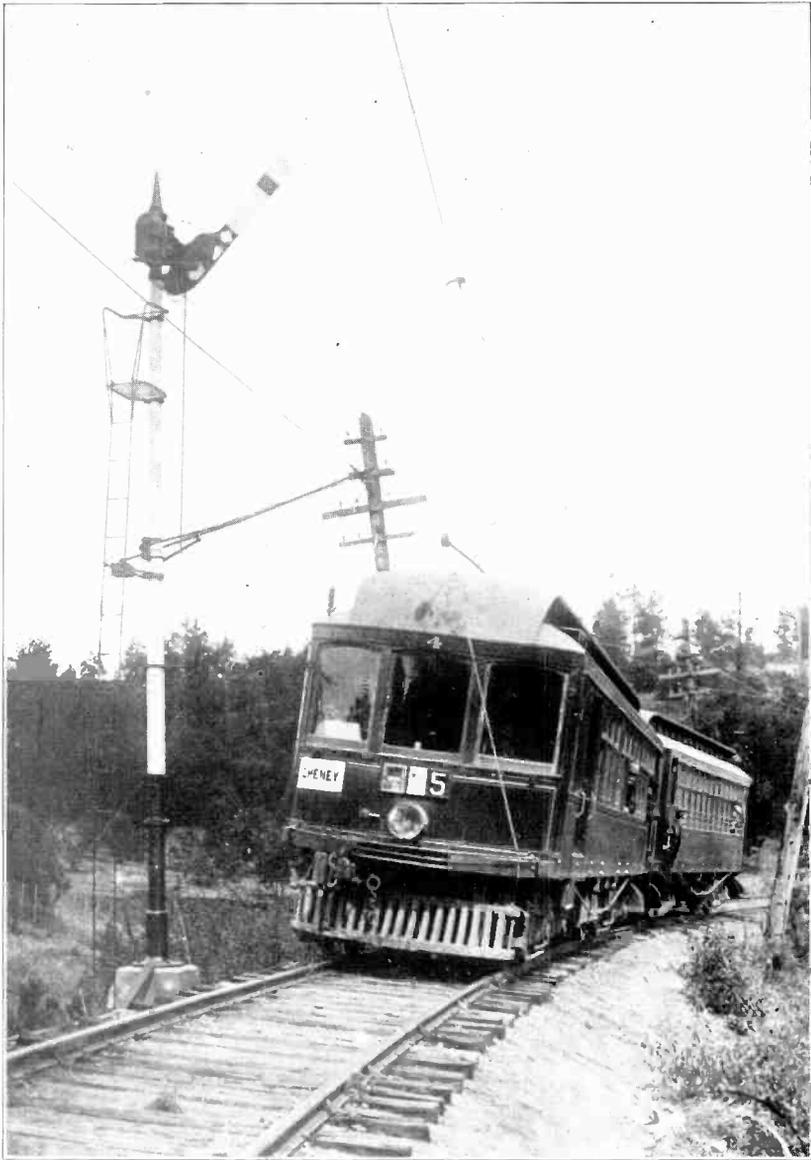
**ELECTRIC AUTOMATIC STOP ON TROLLEY LINE IN WASHINGTON STATE**
