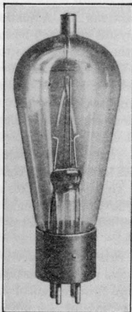
FIG. 488.—Type UX-866 mercury-vapor rectifier tube.
