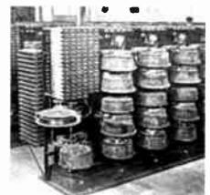
Primer sistema automático de teléfonos patentado por Almon B. Strowger, en 1891, en Kansas City, que eliminó la intervención de operadores.
