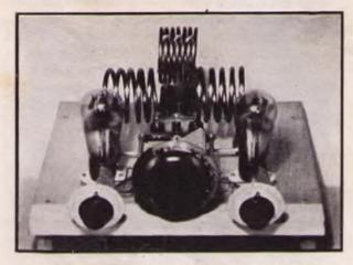
FIG. 708 - A PUSH-PULL OSCILLATOR
