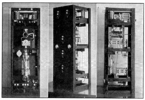
FIG. 929 -- THREE VIEWS OF THE HIGH-POWER AMPLIFIER
