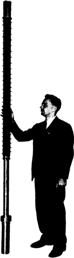
Fig. 4.35. 2-Million-volt precision x-ray tube.<sup>45</sup>
