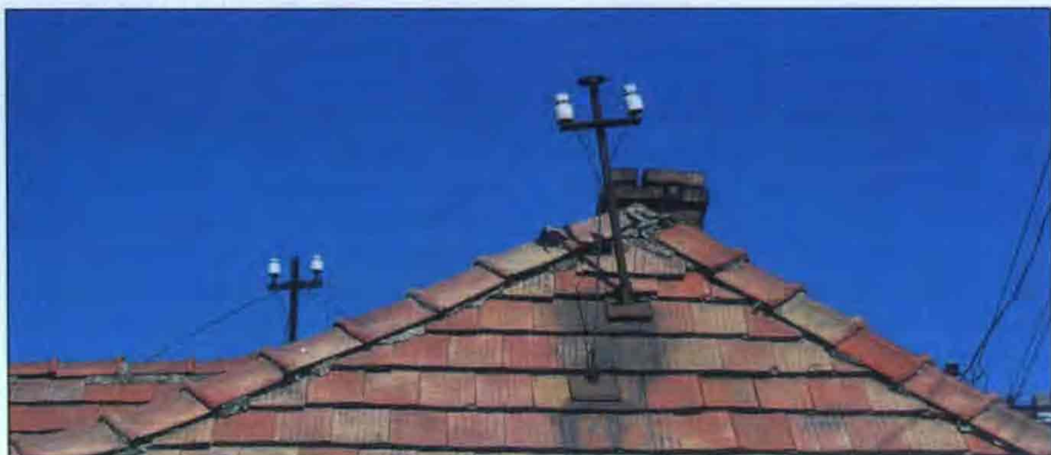
21. ábra. Az egykori vezeték-rádió jellegzetes szerelvényei
