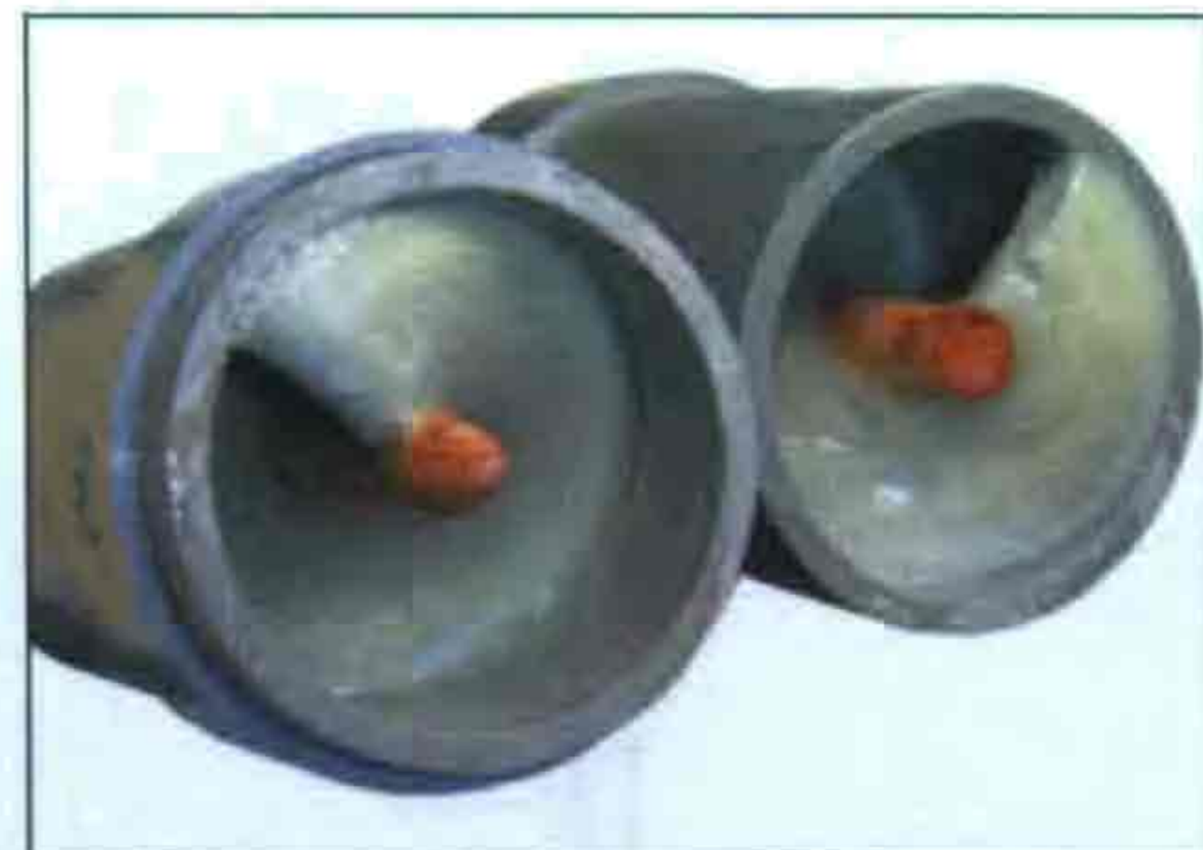
50. ábra. A csőbe ragasztott spirál eldolgozása tömítőpasztával
