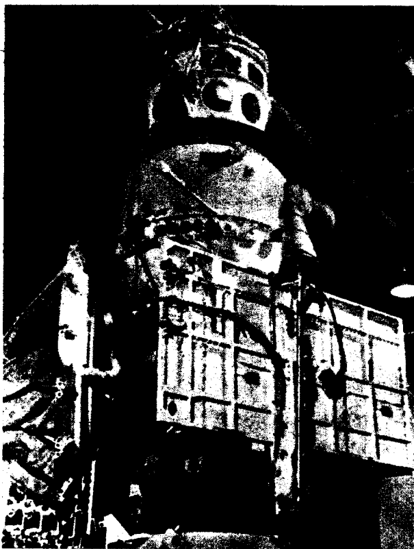
2. ábra. Vénusz—4 rakéta szerelése
