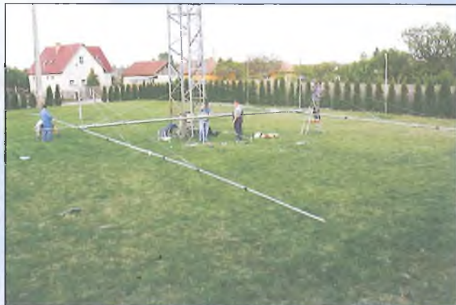
A yagi méreteit jól szemlélteti a toronyra emelés előtt készült fénykép
