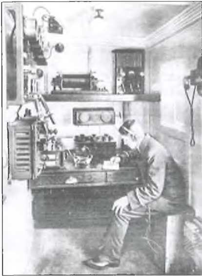
3. ábra. Ez a kép az „S.S. Franconia” gőzhajó rádió-kabinjában készült
