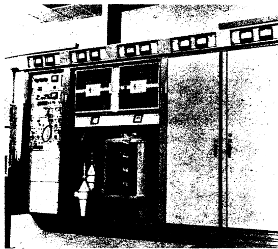
23. ábra. A 4/0,8 kW-os budapesti színes TV-adó szerelés alatt, levett ajtókkal. (Az Elektromechanikai Vállalat engedélyével)
