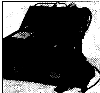
Az annak idején Amerika-szerte használt Keeler-féle Polygraph, azaz hazugságvizsgáló készülék, melynek elektronikáját Striker György tervezte (Associated Research, Inc.)
