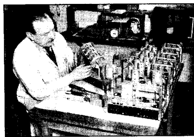
Zavarkereső készülék szerelése
