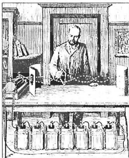
1. ábra. H. Hertz kísérletezés közben Forrás: Hans Günther: Radiotechnik – Das Reich der elektrischen Wellen. Franckhische Verlagshandlung. Stuttgart, 1921.
