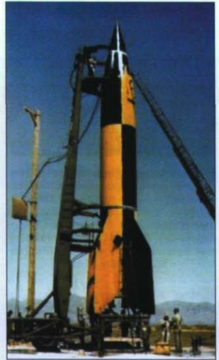
4. ábra. Egy eldobzott V-2 rakéta kísérleti indításra történő előkészítése az Egyesült Államok „White Sand Proving Grounds” rakétakísérleti telepén, az 1940-es évek végén. Az eredeti német szállítójármű hidraulikus emelőjével emelik/billentik a rakétatestet az eredeti indítóasztalra
