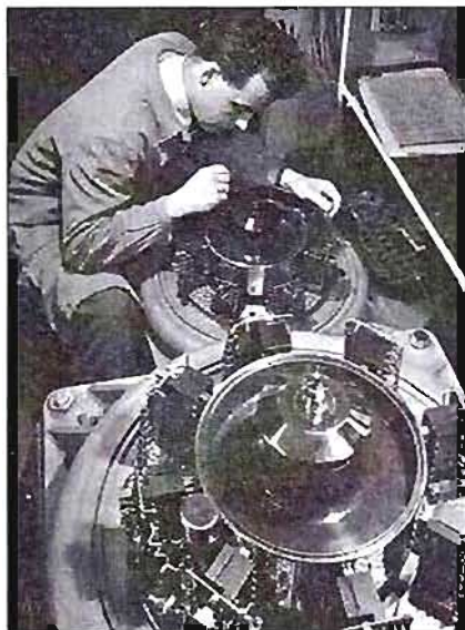
44. ábra. A második dob hozzáépítése a számítógéphez
