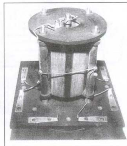
13. ábra. A Marconi 12A típusú rádiogoniométer állótekerce
