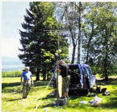
Obr. 3. KV PD 2014, stavba antén stanice OK1RCX/p na kóte Adam v Orlických horách (JO80HC). Vlevo OK1FRT, u stožárku OK1iN. Vysunovací 10m Al stožárky slouží jako podpora drátových antén pro KV a zároveň nesí rotátor s Yagi anténou na 2 m, protože současně s KV PD probíhají také soutěže na VKV
