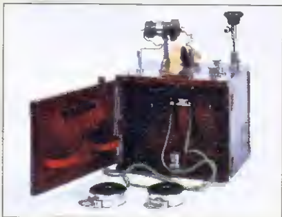
Obr. 6. Popovův přijímač jiskrové telegrafie („telefonní“) se sluchátkem
