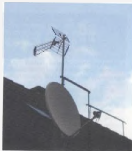
Obr. 1. TV anténa s úhlovým reflektorem a několika řadami direktorů je typem nové antény pro příjem DVB-T v pásmu 470 až 790 MHz (K21 až K60)
