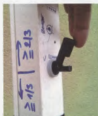
Obr. 3. Nainstalovaný hladinový spínač
