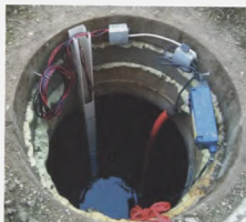
Obr. 6. Vstupní otvor nádrže
