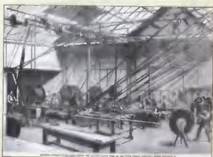
Obr. 6. Vyrobní hala podmorských kabelů s transmisemi
