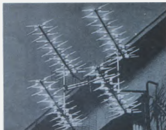
Obr. 1. Anténní soustava sestavená ze zkrácených antén X-COLOR se ziskem kolem 17 dB umístěná v 80. letech v Praze ve Stránských právidelných příjmu rakouské TV na K 32 z Geisbergu u Salzburgu
