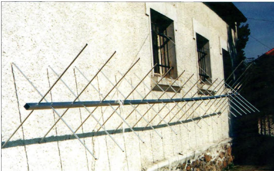
Pour monter les 17 éléments de l'une ou de l'autre polarisation, un système de palan s'avère nécessaire.
