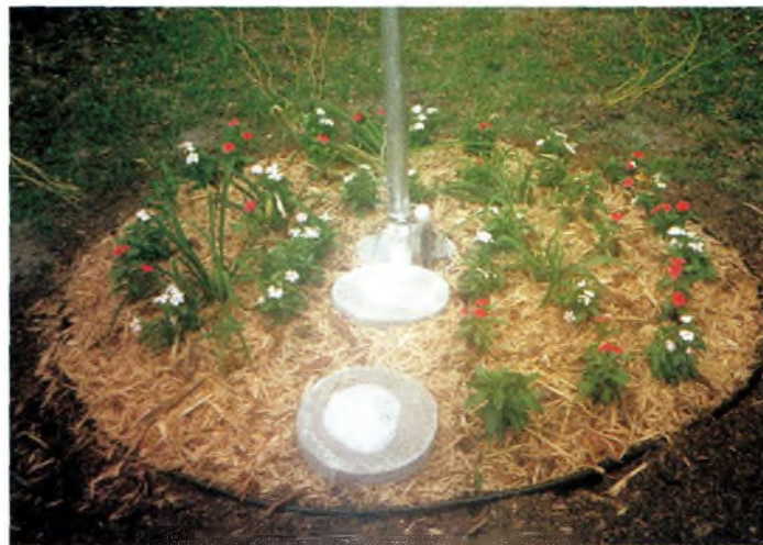
Gros plan sur la base de l'antenne, une fois le plan de sol enterré.
