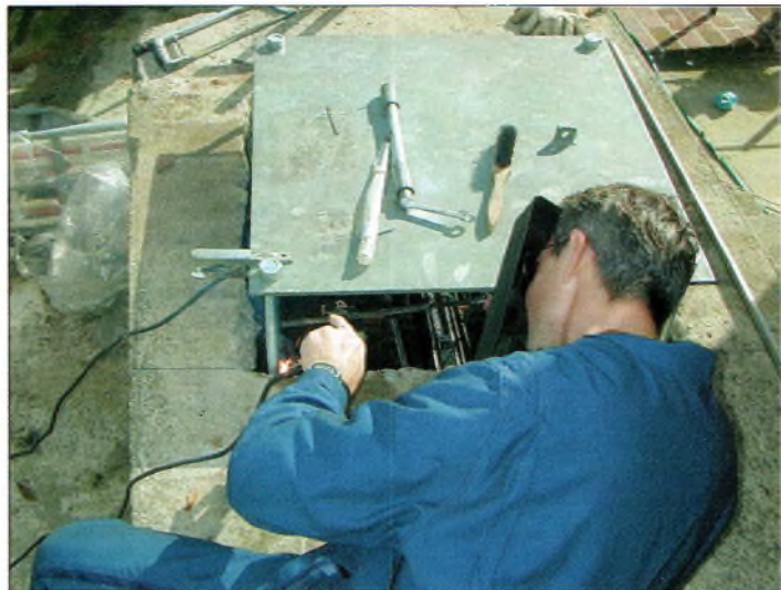
La plaque de 800 x 800 équipée de son système de basculement et d'accroche.
