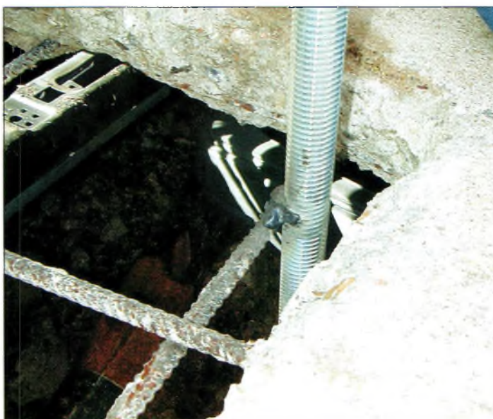
En avant les soudures !
