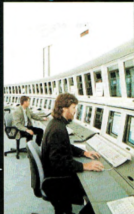
Fig. 4- Salle contrôle satellite METEOSAT.
