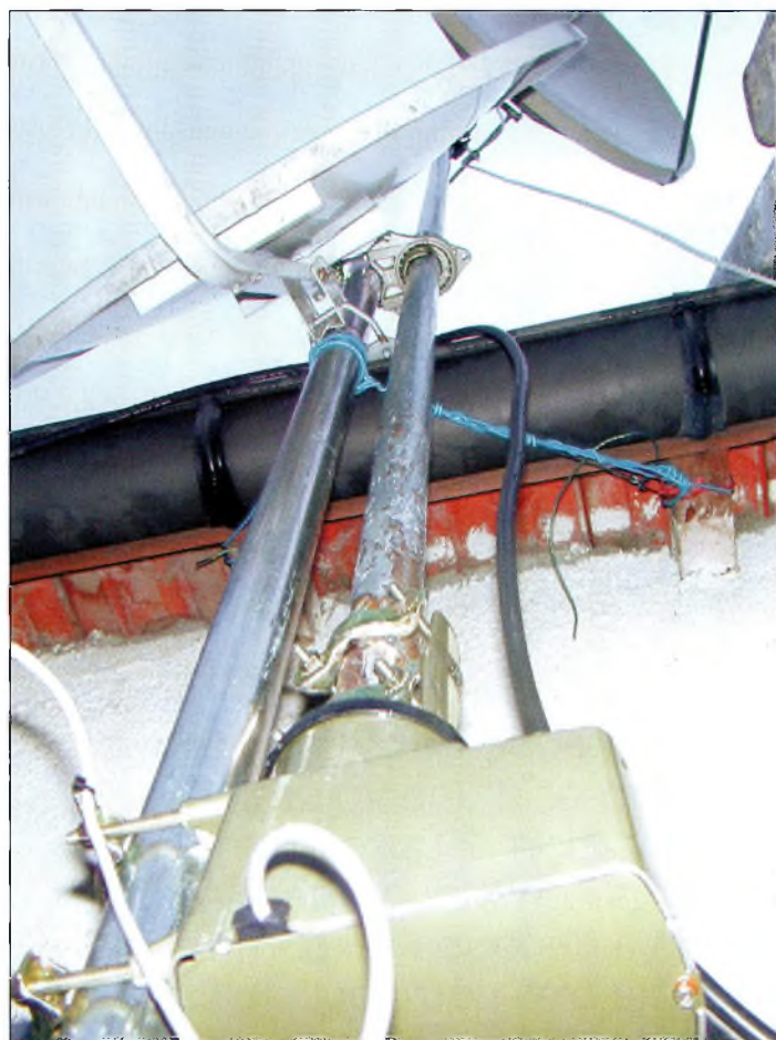
On note ici parfaitement le montage du palier de renfort par rapport au mât, au moteur et à la flèche.
