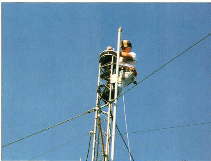
Photo 2- L'auteur fixe le roulement à 20 m du sol.
