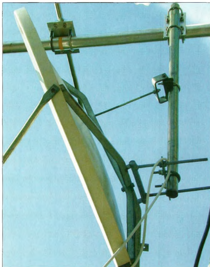
Le boom de l'ITA65 est parfait pour déporter une parabole en résine, donc pas lourde. Notez la barre de guidage supérieure qui sert au réglage de l'élévation, on peut aisément la remplacer par un petit vérin pour plus de précision.
