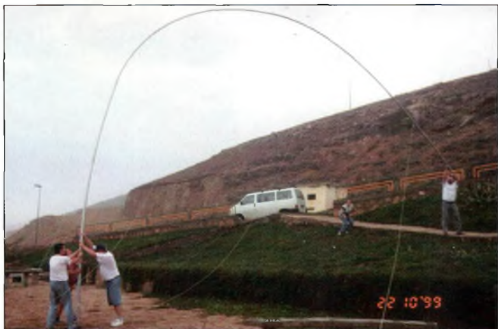
Assemblage de la verticale Titanex 160 mètres.
