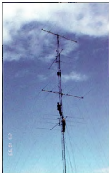
L'un des pylônes de 24 m avec le réseau 4 x 4 pour le 10 mètres.
