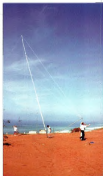
Assemblage de l'une des antennes 80 mètres.
