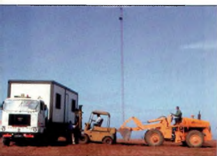
Livraison du container-shack pour les bandes hautes.
