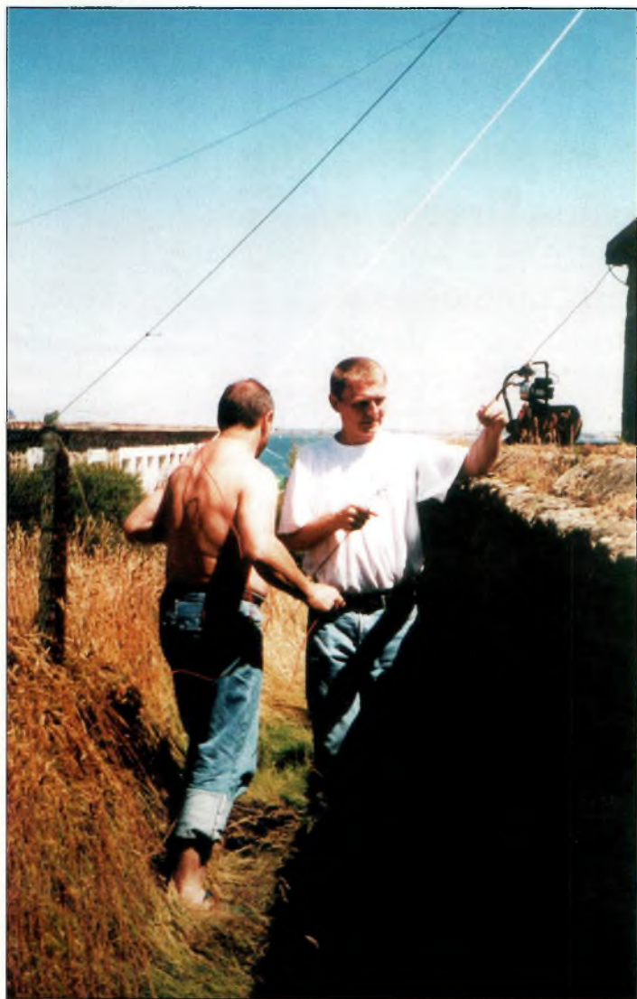
Installation des dipôles.
