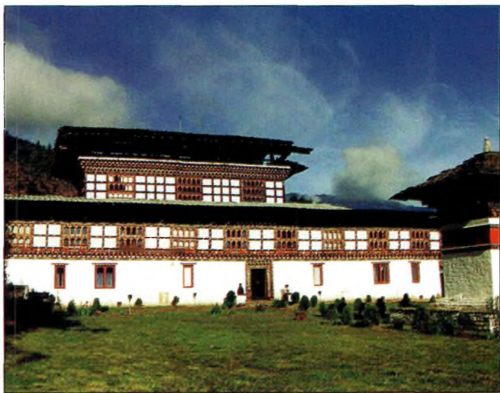
Le site de Paro où l'hôtel surplombe l'aéroport et où le dégagement alentour est optimal.
