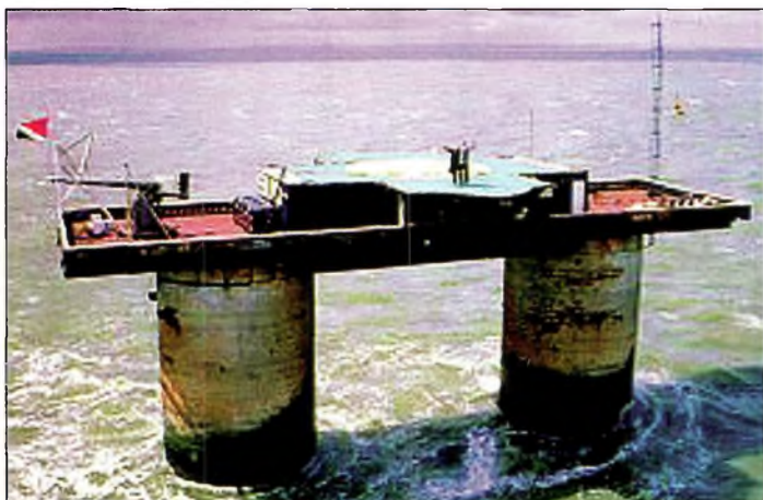
La Principauté de Sealand. Une forteresse artificielle construite au cours de la seconde guerre mondiale pour défendre l'Angleterre contre les raids aériens allemands.
