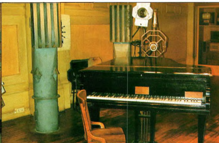
Le premier studio de télévision. Les cheminées qui apparaissent servaient à insuffler de l'air froid dans le local. Il y faisait une chaleur étouffante à cause des nombreux projecteurs.
