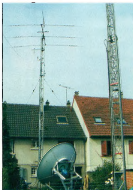
En avant scène, le deuxième pylône de Guy, un 18 mètres autoportant, télescopique et basculant, de quoi permettre toutes les expérimentations sur les antennes sans mettre sa vie en péril.
