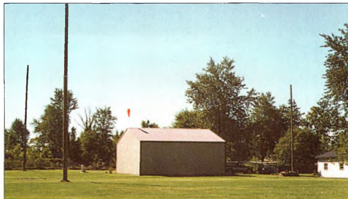
Trois des quatre poteaux formant les coins de l'antenne cadre. Le positionnement du quatrième poteau a nécessité un peu d'élagage des arbres. (Photos de l'auteur)
