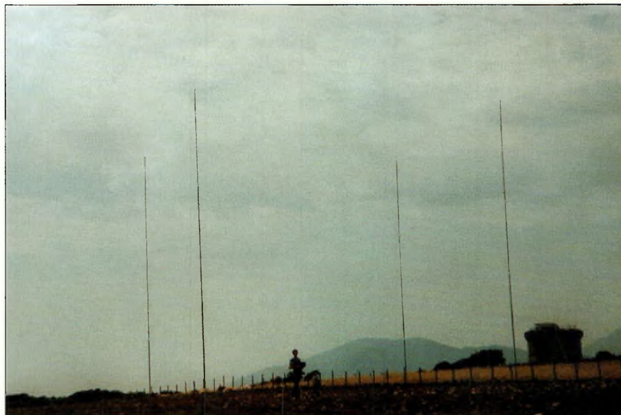
L'antenne Four Square Array, composée de 4 quarts d'onde en phase.
