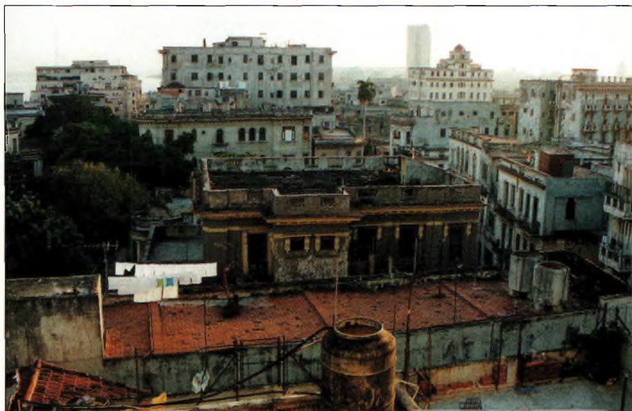
Vue sur La Havane. Une ville dont la construction semble inachevée...
