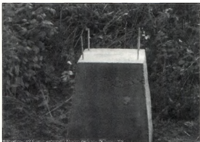
Ce cliché montre une embase de pylône typique, prête à recevoir le pylône. Les tiges filetées sont visibles dans chaque coin du bloc de béton.
