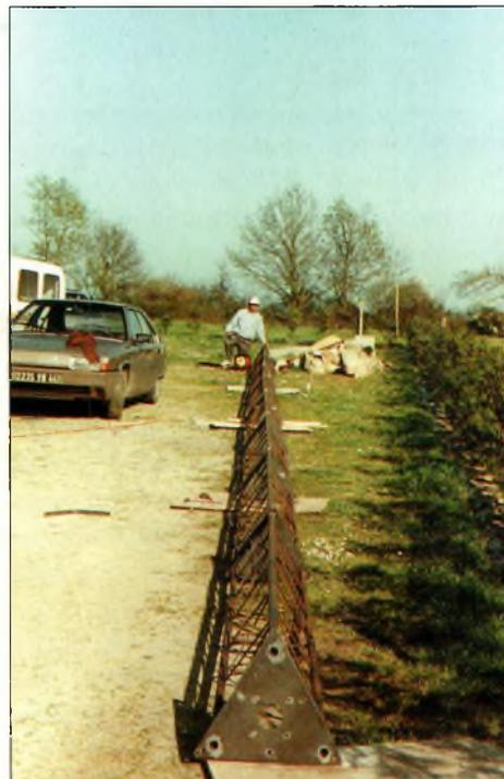
Photo 3. Le pylône home-made avant le passage au bain.
