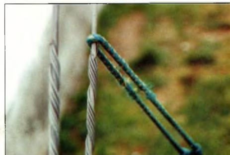
Photo 5. Simple et pas cher, voici une astuce de F6EKS pour empêcher la vibration des haubans.
