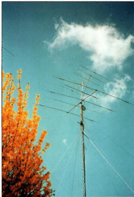
Chez lui, le pylône bandes WARC : 3 éléments 18 MHz, 4 éléments 24 MHz et une Delta-Loop 10 MHz. Au-dessus, l'antenne 50 MHz.
