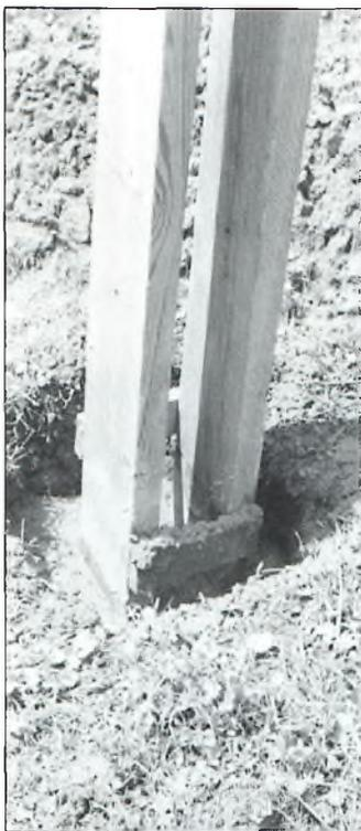
*L'embase du mât comporte les deux planches en bois qui prennent en sandwich le tube en PVC. Des fondations en béton sont nécessaires pour une structure solide.*
