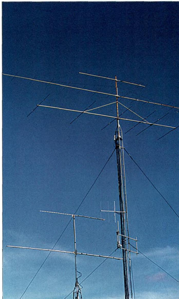
**Le système d'antenne de W5UWB. John a en partant du haut 11 éléments sur 222 MHz sur une Yagi à 17 éléments pour la bande des 2 mètres sur une beam 6 mètres à 6 éléments de conception W1JR. Sur l'autre pylône une Yagi à 35 éléments pour 1296 sur une conception K1FO à 25 éléments pour le 432 MHz. (Photo de W5UWB)**
