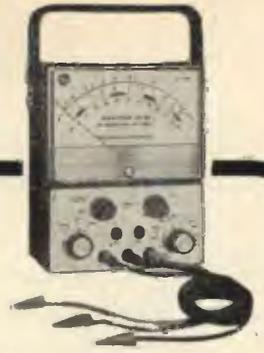
Con questo nuovo provatransistori RCA portatile si possono provare i transistor anche nel circuito stesso in cui sono impiegati, senza doverne dissaldare i terminali.
