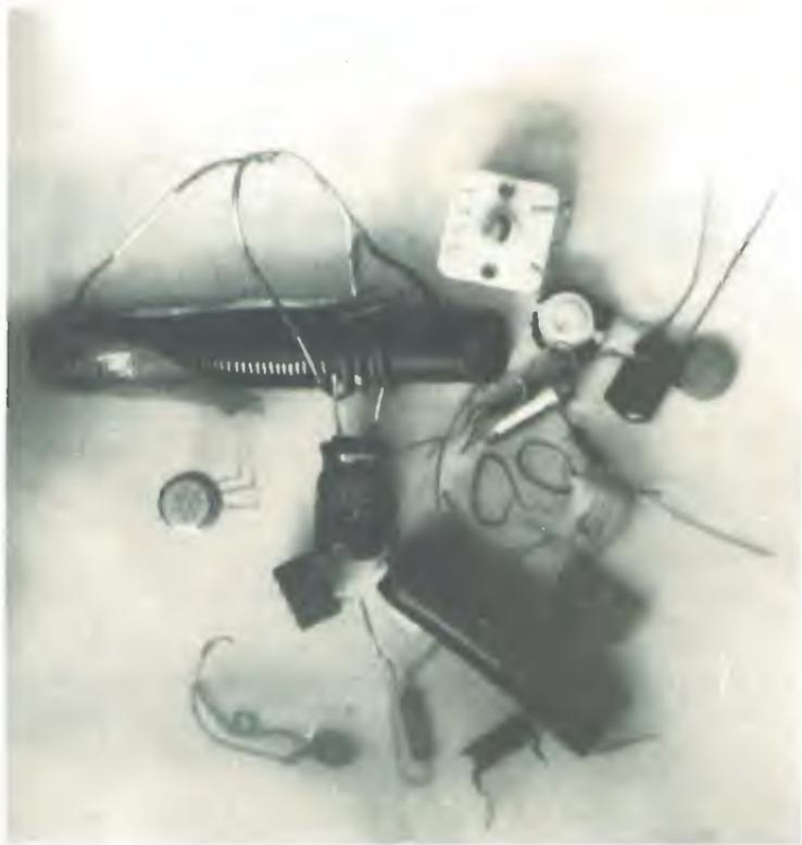
*Un « mucchietto » di componenti, usati per l'AP811. Si distinguono in alto, la bobina su ferrite, il variabilino, un trimmer; in centro a sinistra un paio di integrati, poi vari condensatori e resistenze.*
