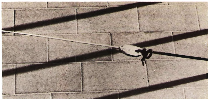
La parte terminale di uno dei due bracci del dipolo degli 80 m. Attacco nella parte bassa della ringhiera di uno dei balconi laterali.
