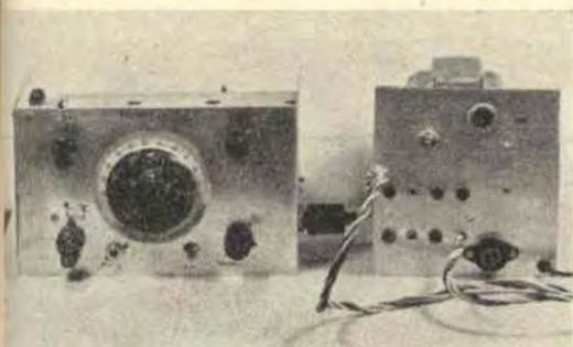
Pannello del ricetrasmittitore e dell'alimentatore.
