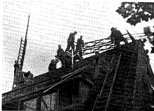
Het overeind zetten van de toren. Aan een zijde is deze eerst met scharnieren aan het voetstuk bevestigd
