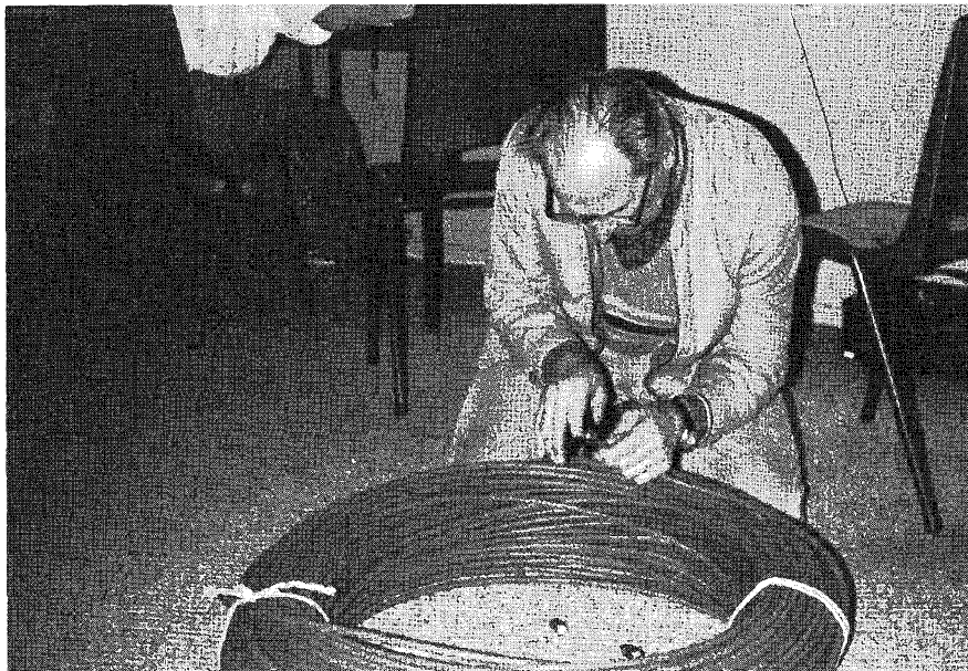
In totaal werd er 700 m coaxkabel uitgerold. (foto: PAoJMH)
